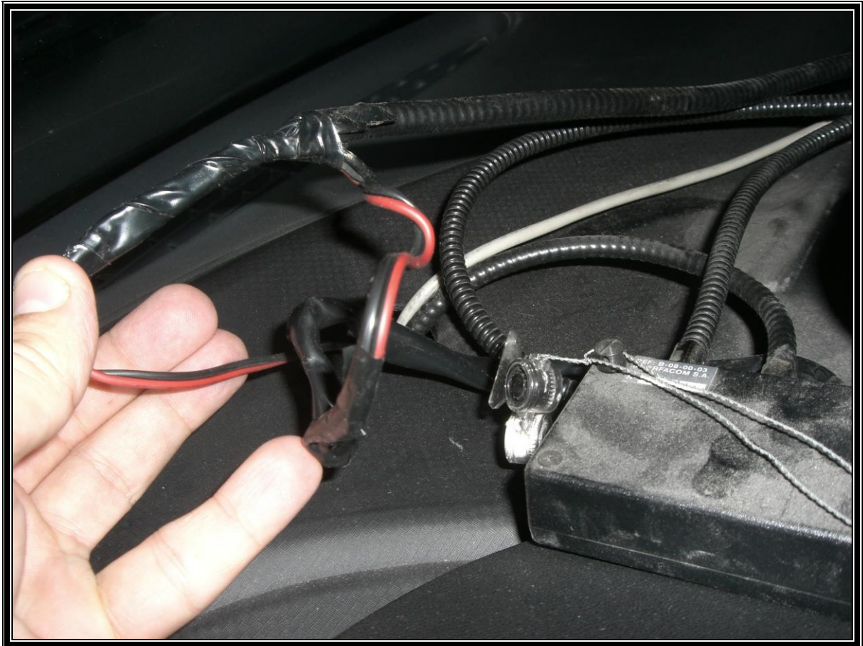
TAXÍMETRO CON CABLEADO SUELTO DESENGARZADO DE LAS MANGUERAS BLINDADAS
